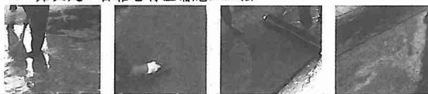
1、润湿基层 2、涂抹水泥浆 3、铺贴卷材 4、搭接密封
