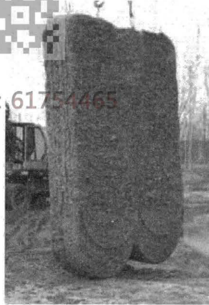
图 9-5-24 CSM 工法施工形成墙体
