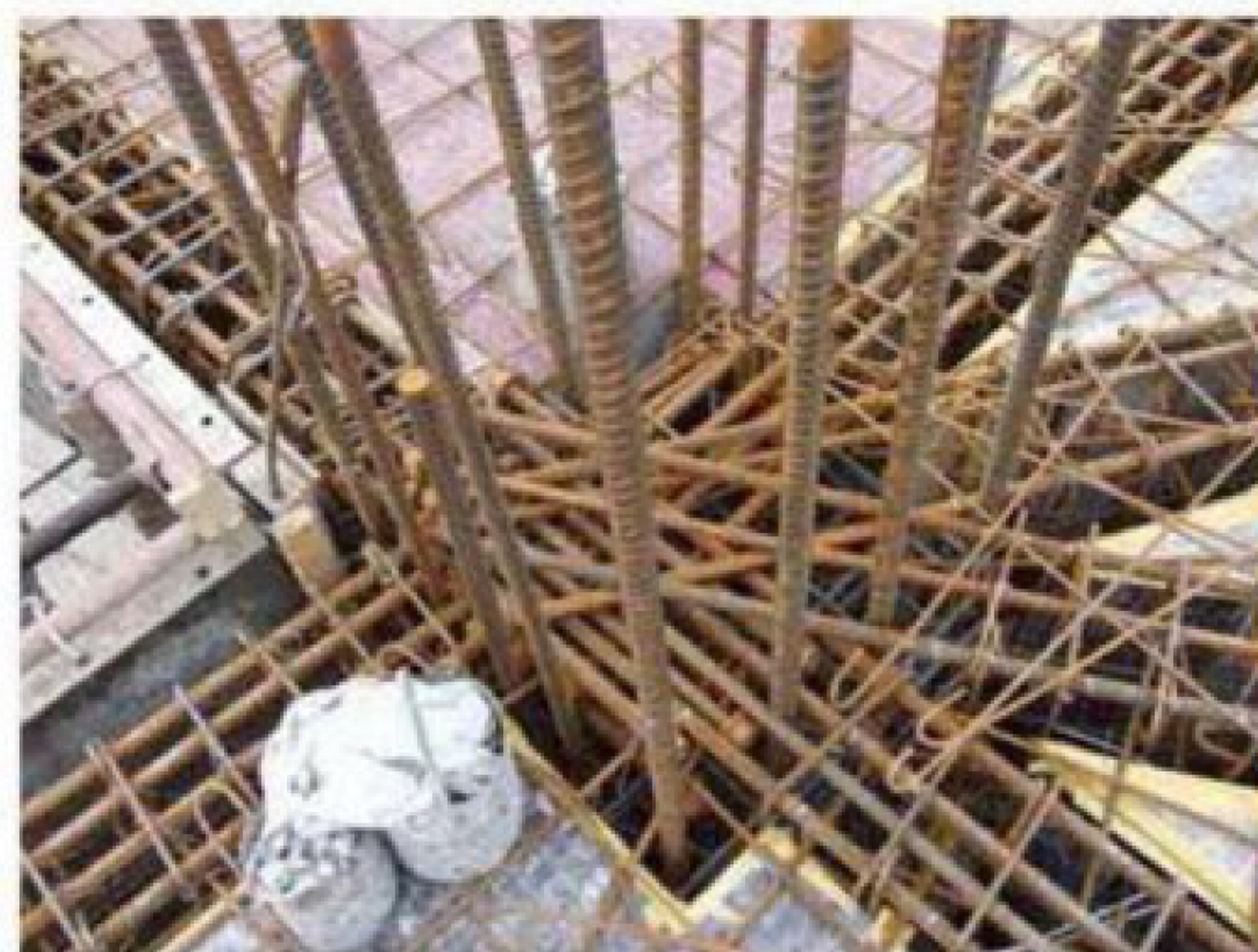
现浇混凝土结构-梁柱节点
