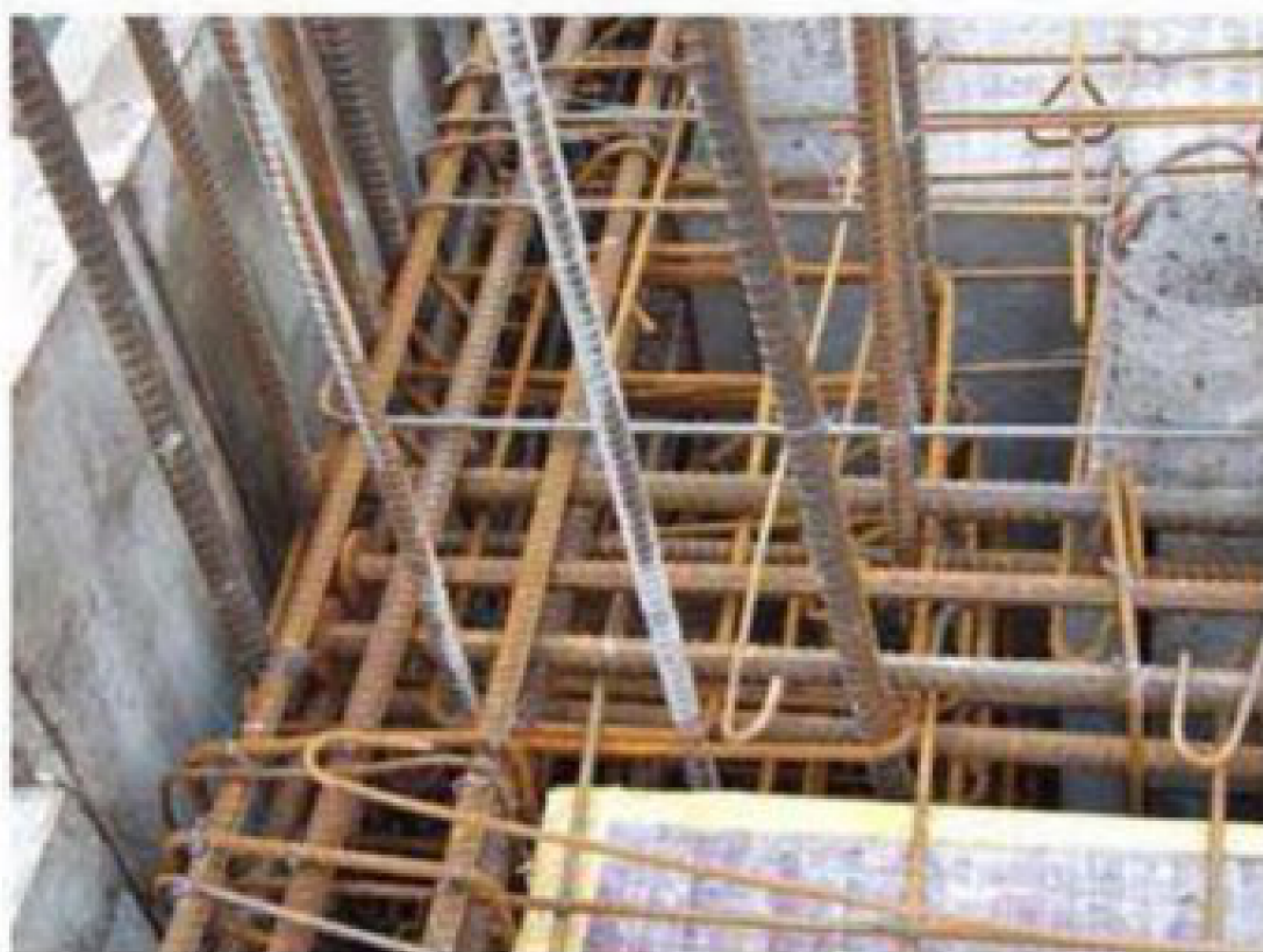
现浇混凝土结构-梁柱节点
