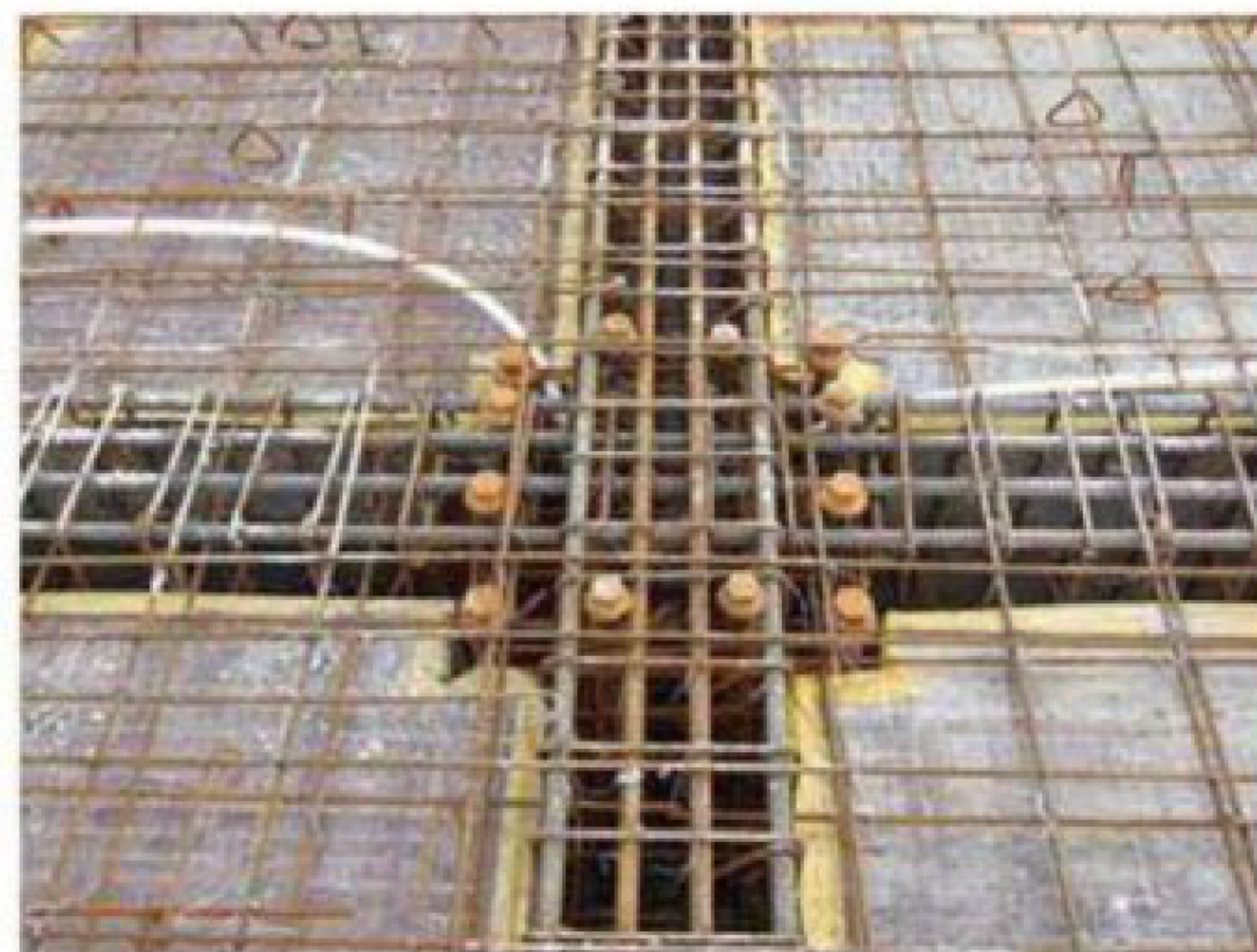
现浇混凝土结构-梁柱节点
