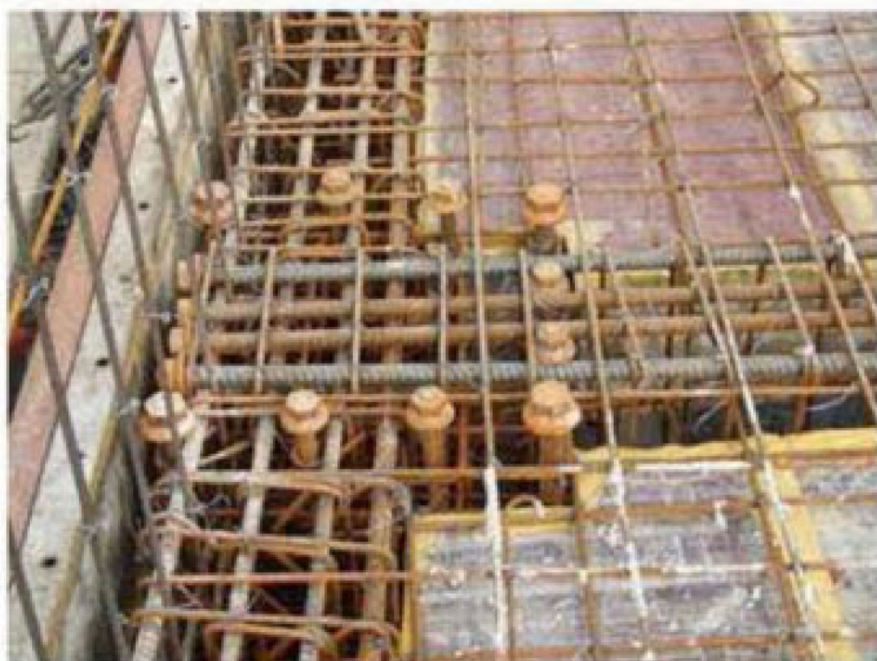
现浇混凝土结构-梁柱节点
