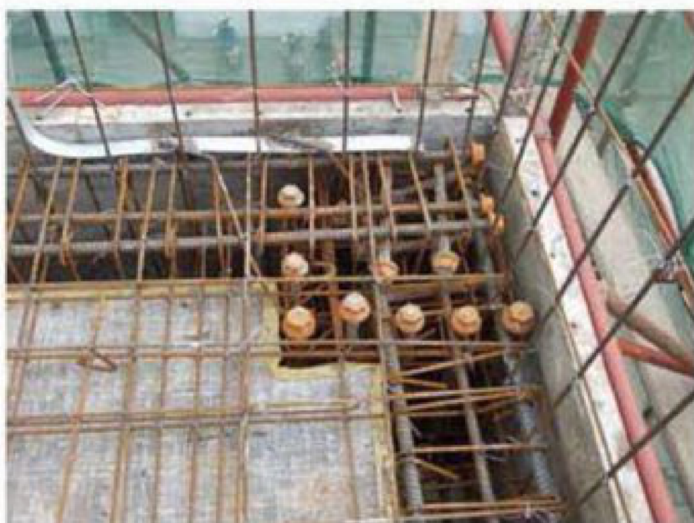
现浇混凝土结构-梁柱节点
