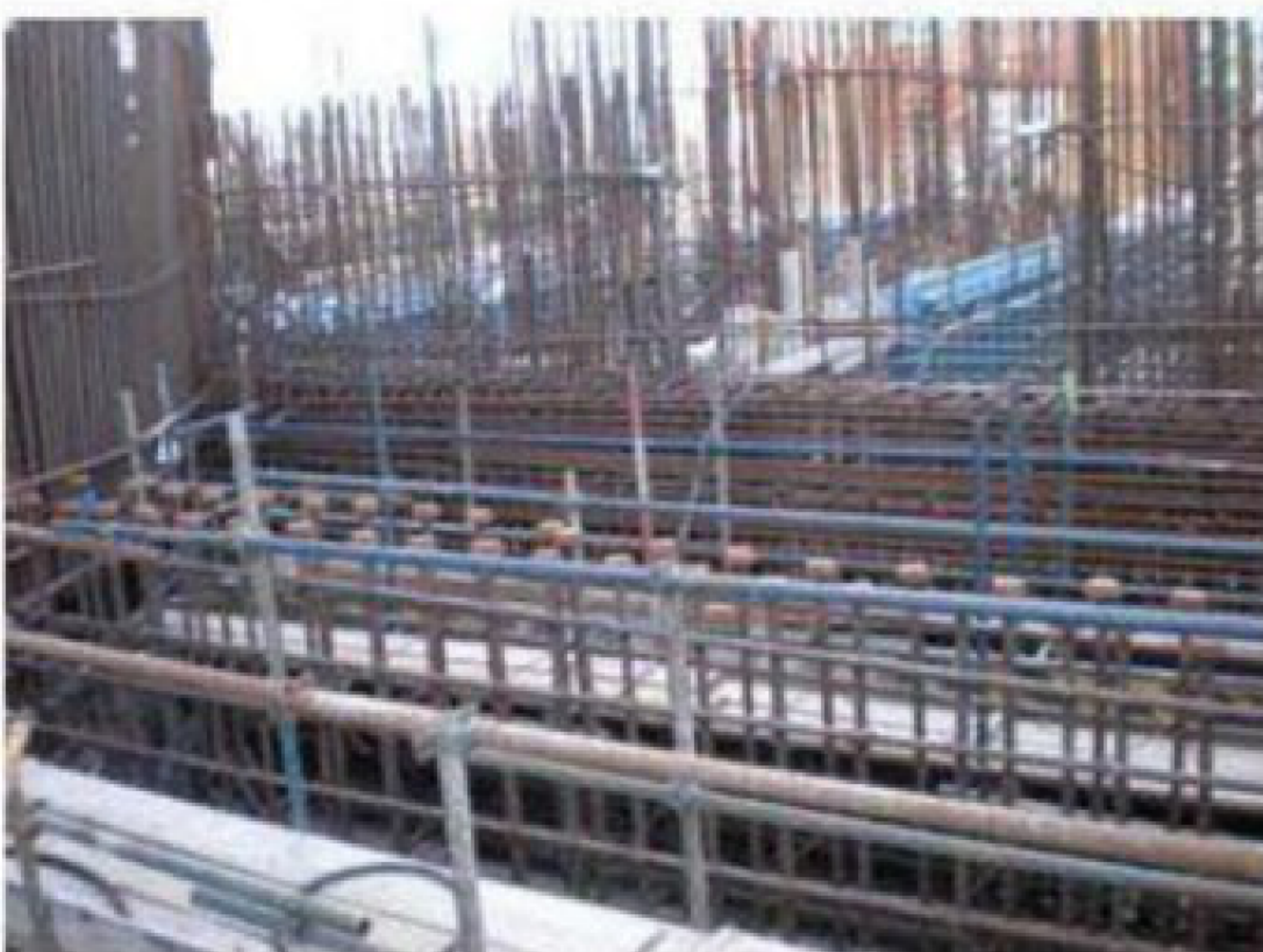
现浇混凝土结构-剪力墙
