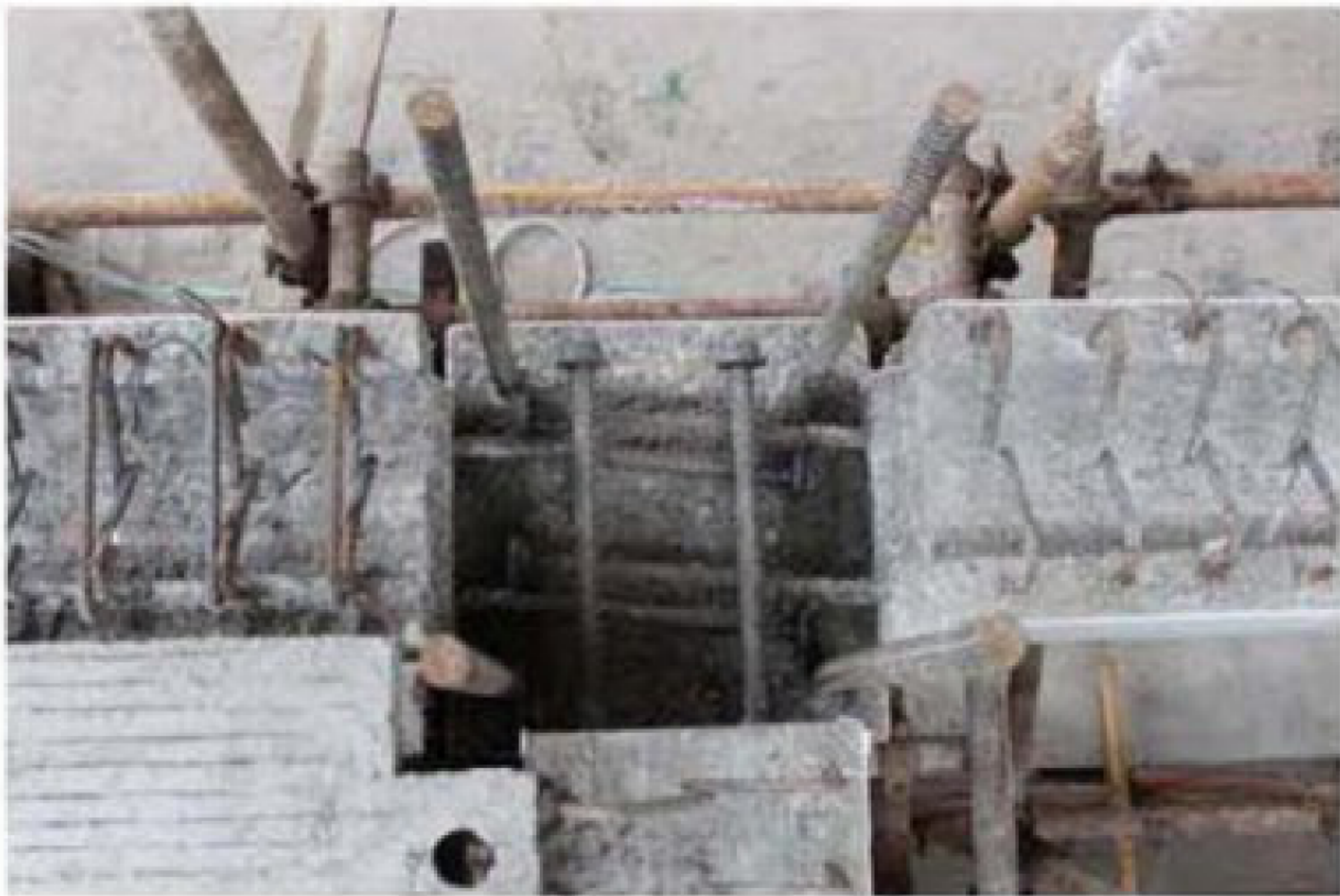
装配式混凝土结构-梁柱节点
