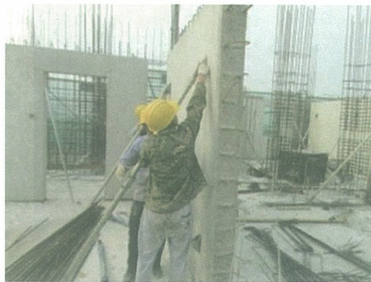
④ 墙板支撑安装
