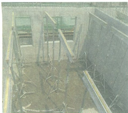
① 叠合板下支撑安装
