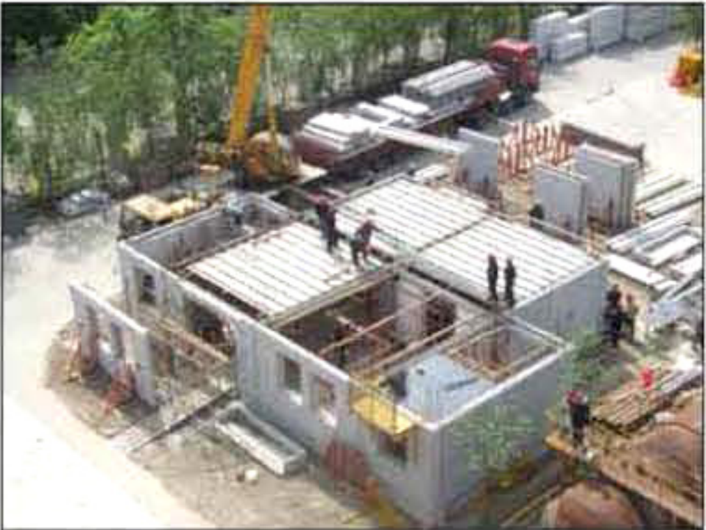
(b) 预制叠合板底板支撑吊装
