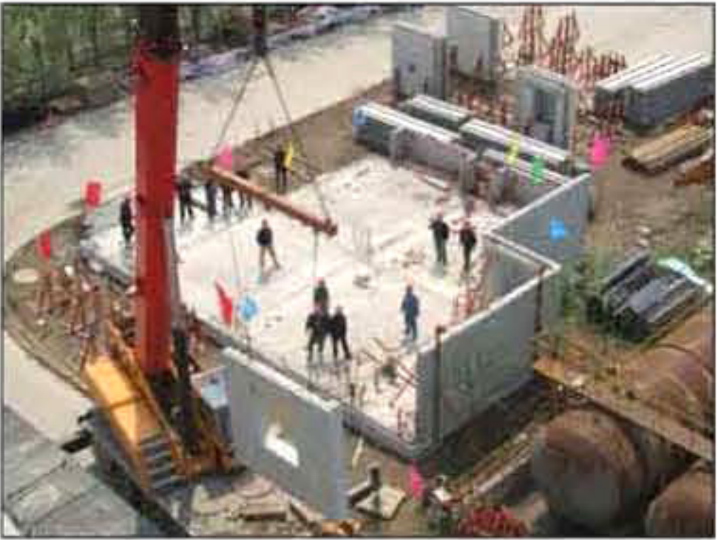
(a) 预制剪力墙板吊装
