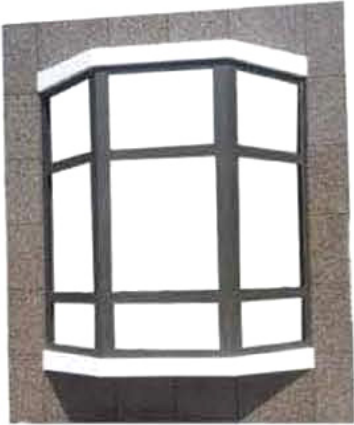
(b) 预制混凝土花岗岩饰面飘窗板
