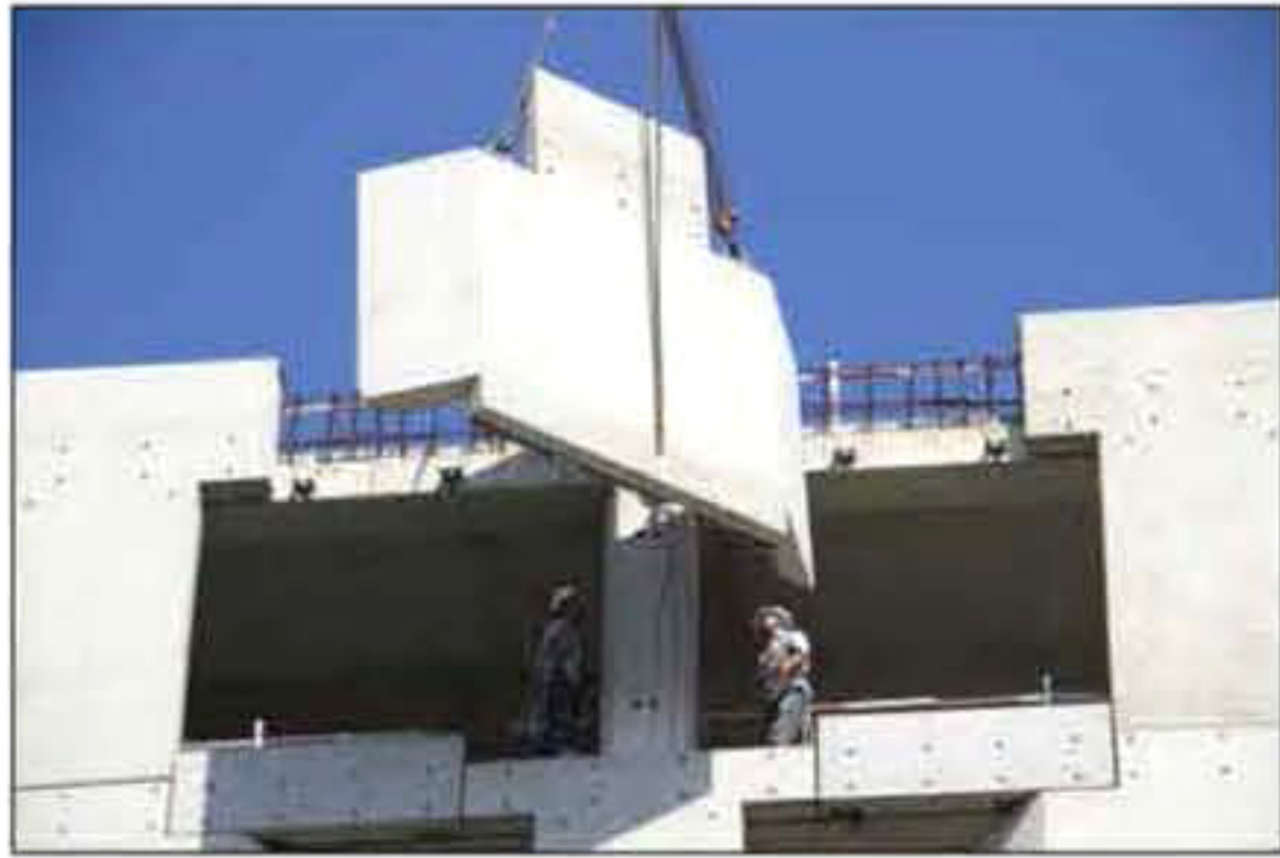
(c) 夹心保温外挂墙板
