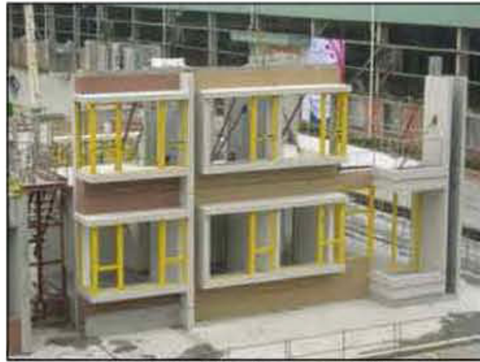
(b) 窗台外墙样板房安装
