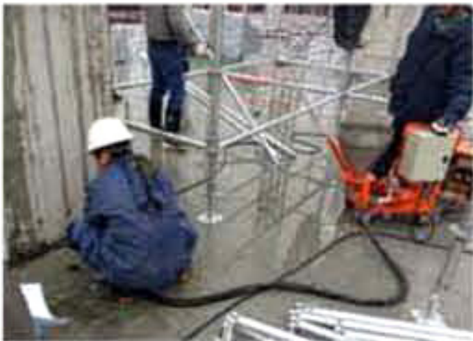
图L.6 电动灌浆泵现场应用
