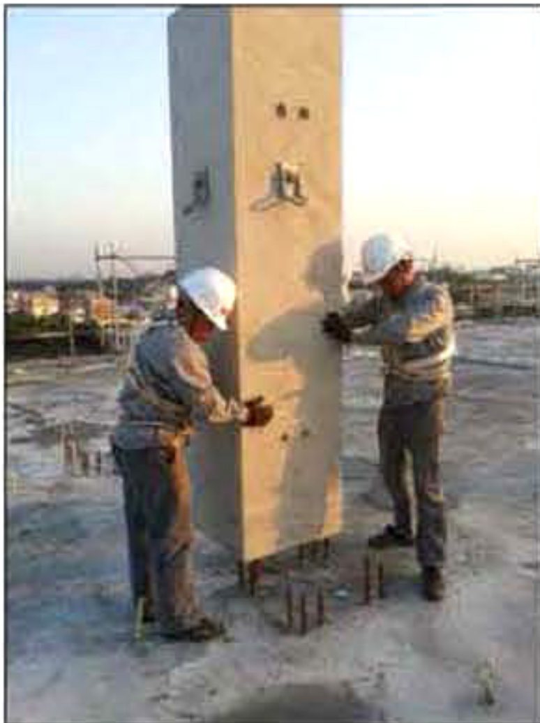
(b) 预制混凝土柱安装
