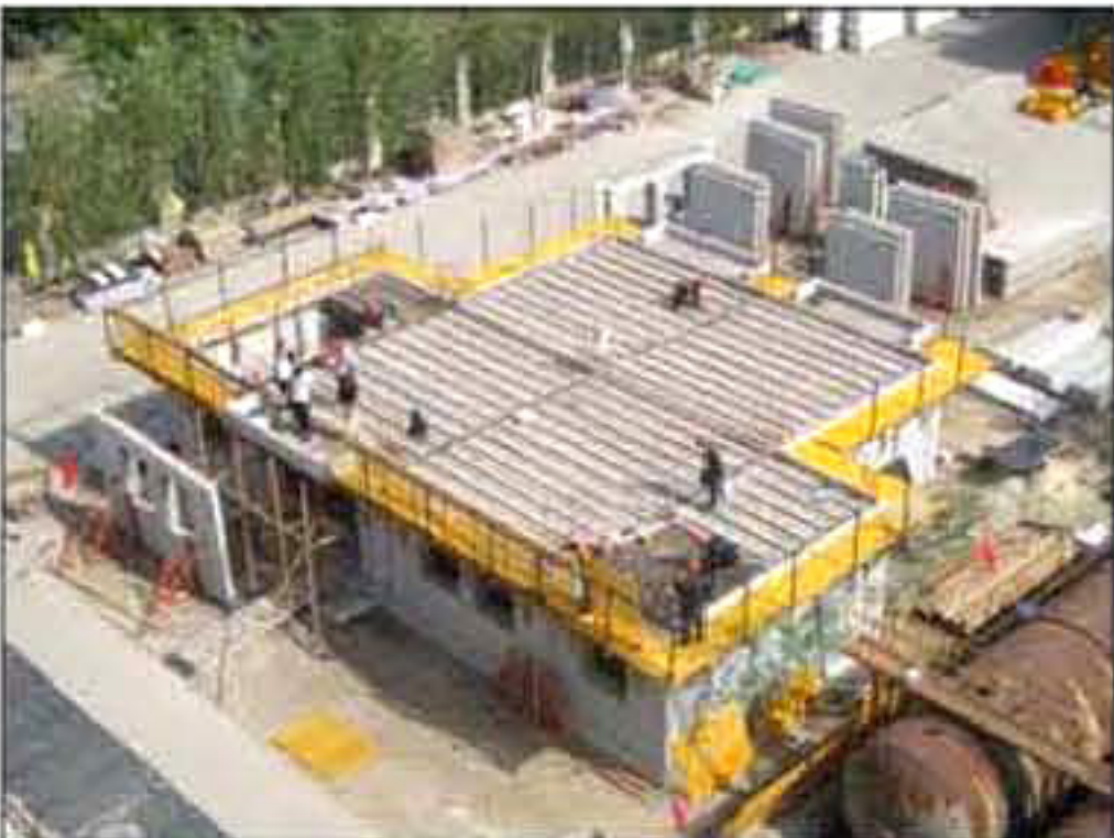
(c) 叠合板现浇层钢筋绑扎
