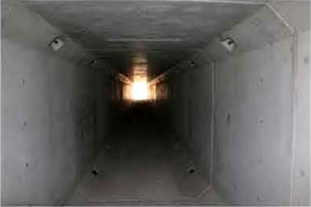
(b) 安装完工后箱涵内部
