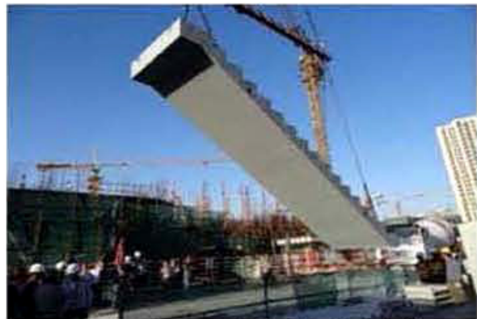
图B.6 预制构件吊装
