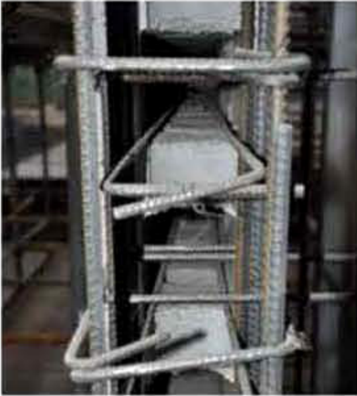
(d) 穿设墙体水平钢筋
