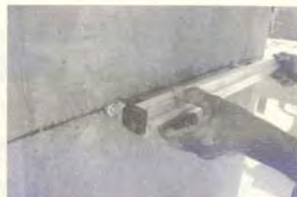
图8 将龙骨插入可调式定位部件
