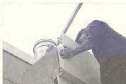
图10 将板边插入龙骨卡槽
