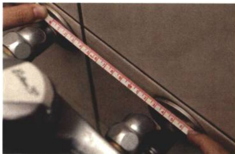
① 装设淋浴柱前，须先用量尺量冷、热水龙头的水管管距。
