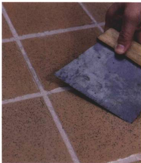
① 金刚砂磁砖不仅防滑，亦有防刮效果。
