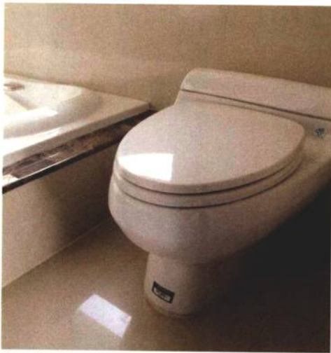
① 马桶施工时必须注意排粪管距。
