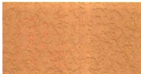
工法 3：利用镘刀平抹方式，施与不同力道镘涂，表面有颗粒状，视觉及触感特别。
