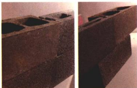
① 空心砖砌墙的两工法：对齐平直而上的日式砌法（左）与交错重叠而上的英式砌法（右）。
