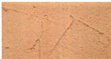
工法 2：以镘刀制造压陷痕迹，为压镘做法，做出表面不平整模样，常用于造型壁面，有装饰空间效果。
