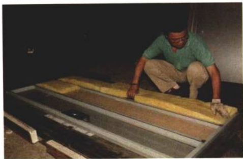
① 门扇内层铺设隔音棉，可吸收声音，加上支架间隔，可加强硬度。
