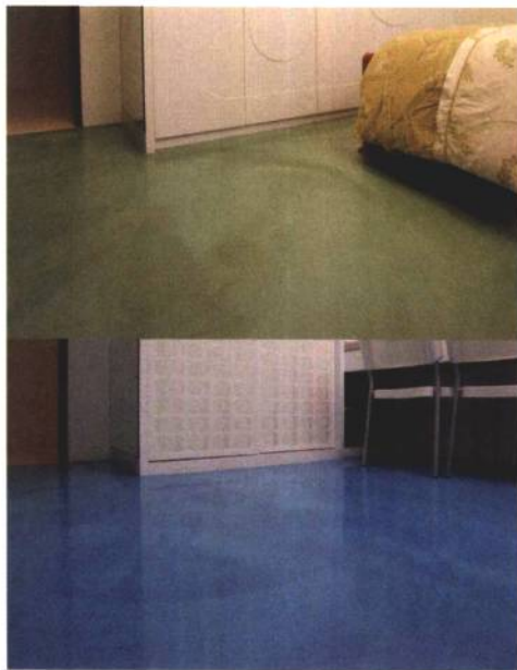
① 盘多魔为水泥基底，可添加任何颜色。
