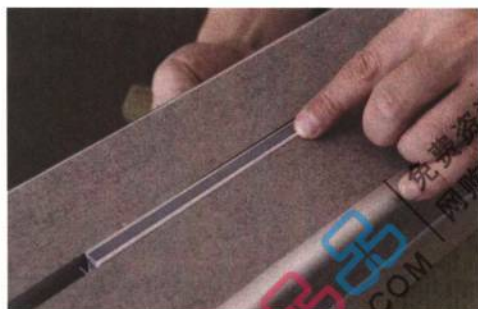
① 运用于间缝的伸缩条的设计，解决热胀冷缩的问题。
