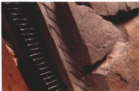
① 木质墙面施工在涂水泥浆前，须加上铁网以增加附着力。
