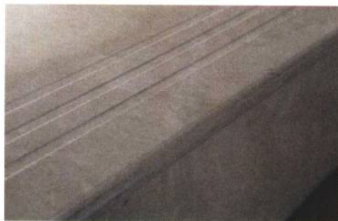
① 担心止滑垫不够美观，可直接在梯面做上4~5条止滑沟，同样有防滑功能。
