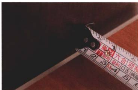
① 铺设抗耐磨地板收缩缝应保持约 8 毫米的间隙。
