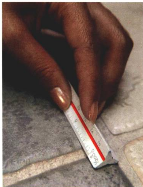
① 自行铺设时，建议沟缝要留约 3 毫米宽。
