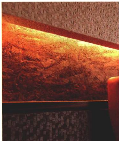
① 定向纤维板通常用作装饰或结构用材。
