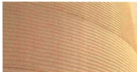
工法 4：以镘涂工法制造滑顺线条，呈现现代风感觉，可用于壁面及天花板。
