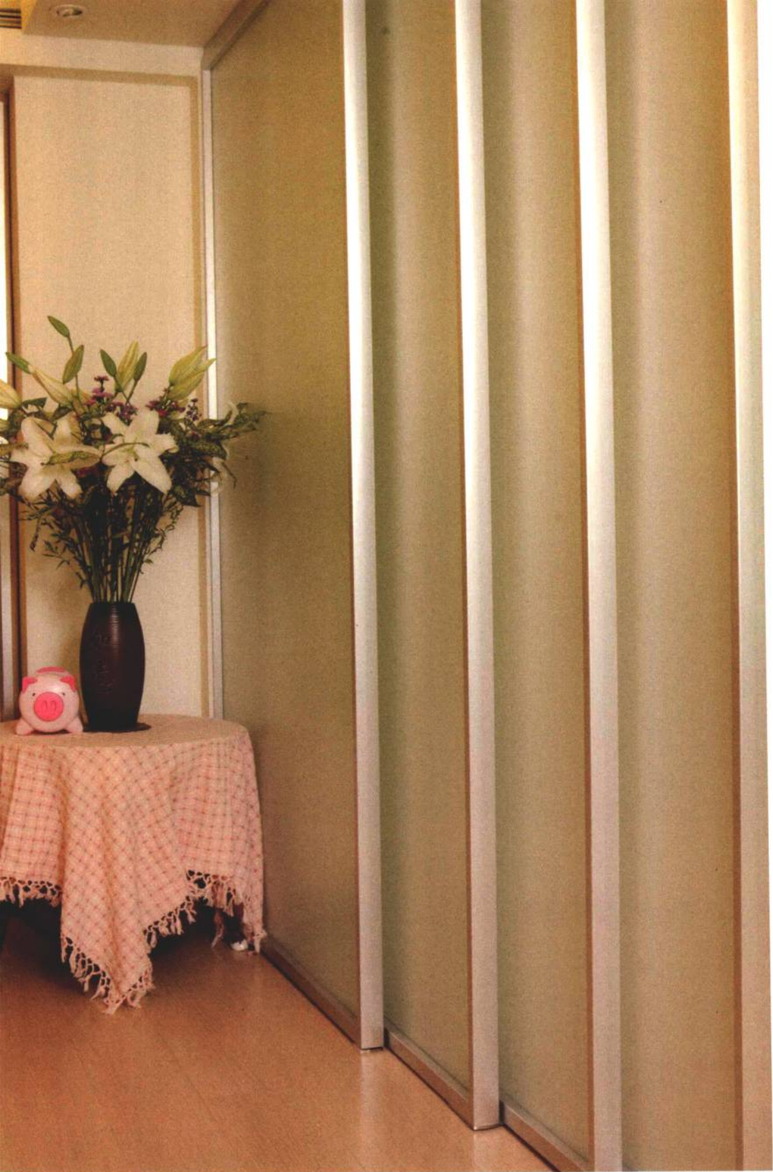
① 玻璃活动拉门固定方式分为悬吊式与落地式两种，图为落地式拉门。
