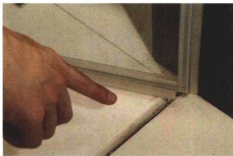
① 即使地面有高低差，也可制作无门槛淋浴门。
