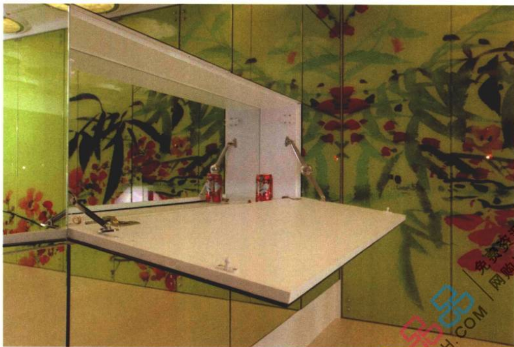
① 影像玻璃的制作方式和夹布玻璃相同，须先将选出的影像输出后，夹在双层玻璃中。
