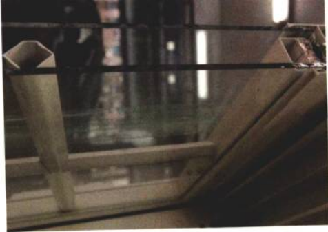
① 双层玻璃气密窗的隔音效果更佳，两层玻璃间设中空不锈钢管，具防盗功能。
