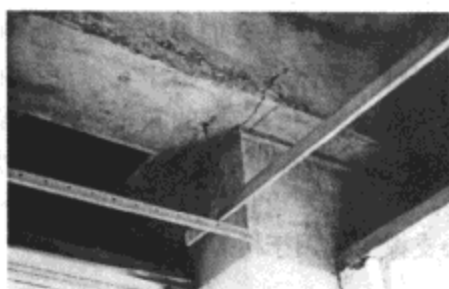
(a) 8层柱、梁裂缝
