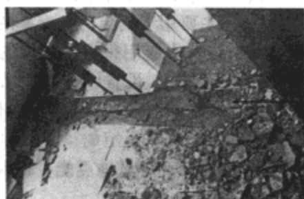
(b) 电梯井边的楼板裂缝
