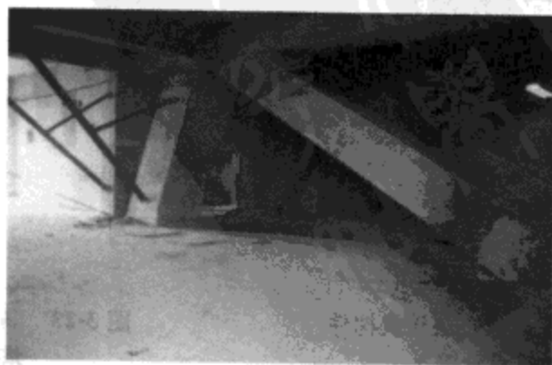
图 3-25 北京香格里拉饭店的斜撑式转换
