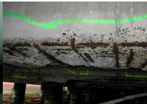
构件老化、劣化问题凸显
