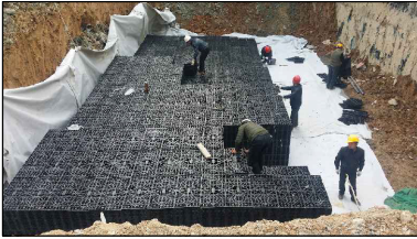
模块式雨水蓄水池安装示意
