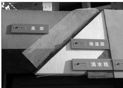
照片五：窗上口构造
