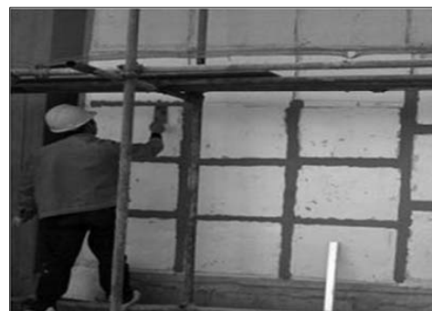
照片八：保温板粘贴完成效果
