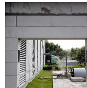
加气配筋过梁示例
