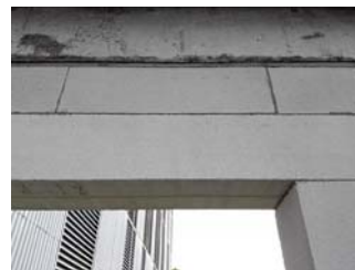
顶部塞缝示例
