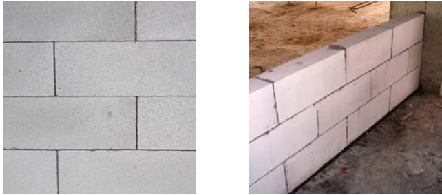
砌块墙体薄层砌筑示例
