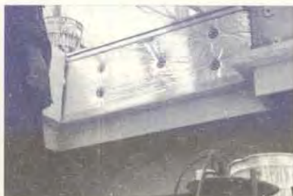
图9 将玻璃棉保温层用尼龙胀栓固定
