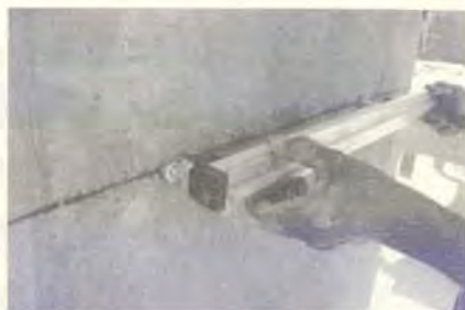
图8 将龙骨插入可调式定位部件
