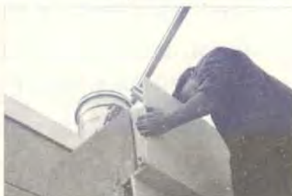
图10 将板边插入龙骨卡槽
